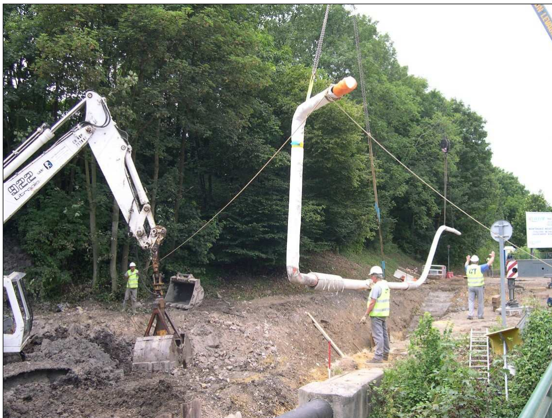
Illustration d'une baïonnette en cours de pose
