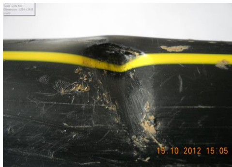
barre à mine / canalisation PEHD gaz MPB
