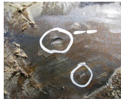
pioche / canalisation acier gaz HP
